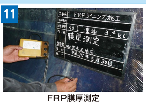
8 FRPライニング施工(紫外線硬化樹脂貼付法)
